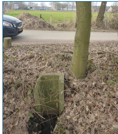
Relict waterinlaatconstructie vloeïweide aan de Molenstraat, 2019
